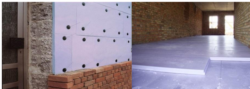
Рис. 1. Применение пенополистирольных плит при утеплении стен
